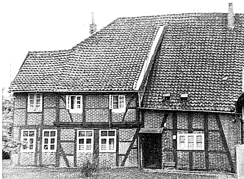
Kirchvordener Straße 48, im 19. Jahrh. erbaut, mit erhöhtem Kniestock im Wohnteil.
