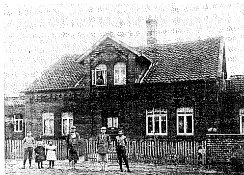
Back- und Wohnhaus, Kirchvordener Straße 10, 1896 erbaut.
