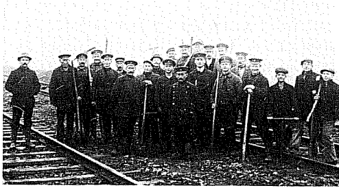
Eisenbahner bei Gleisbauarbeiten in Vöhrum (1915). In Uniform Rottenführer Friedrich Giere - vorn 5. von links Heinrich Klusmann - vorn 10. von links Ernst Klusmann - dahinter Heinrich Brandes, Heinrich Giere - vorn 4. von rechts Heinrich Meyer - vorn 5. von rechts Heinrich Behrens.
