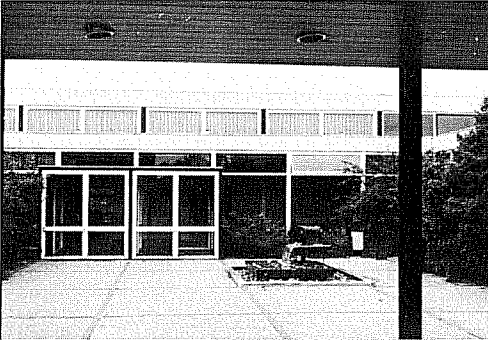
Haupteingang zum Dorfgemeinschaftshaus
